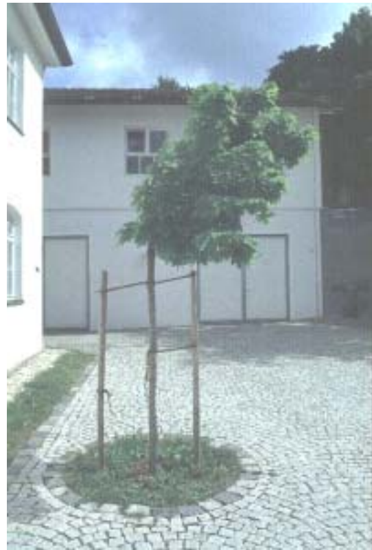
Zu nah am Haus: Eine Dachlawine halbierte den Kugel-Ahorn.
